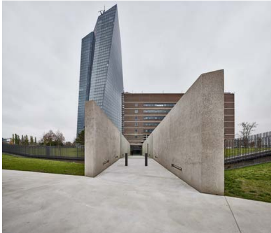
Blick auf die Rampe
