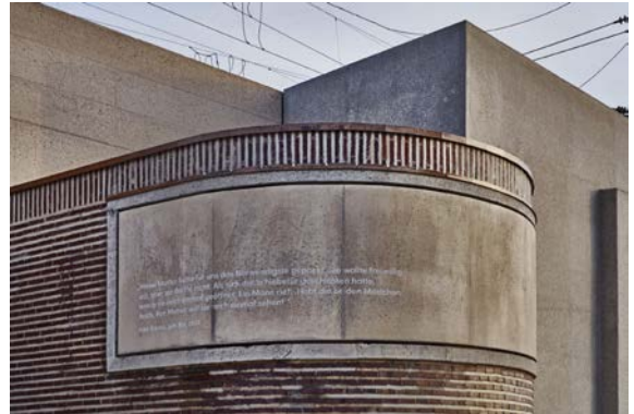
Blick auf das Stellwerk
